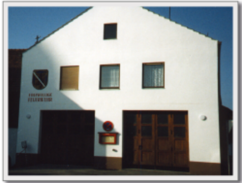
Gerätehaus nach der Renovierung 1993
