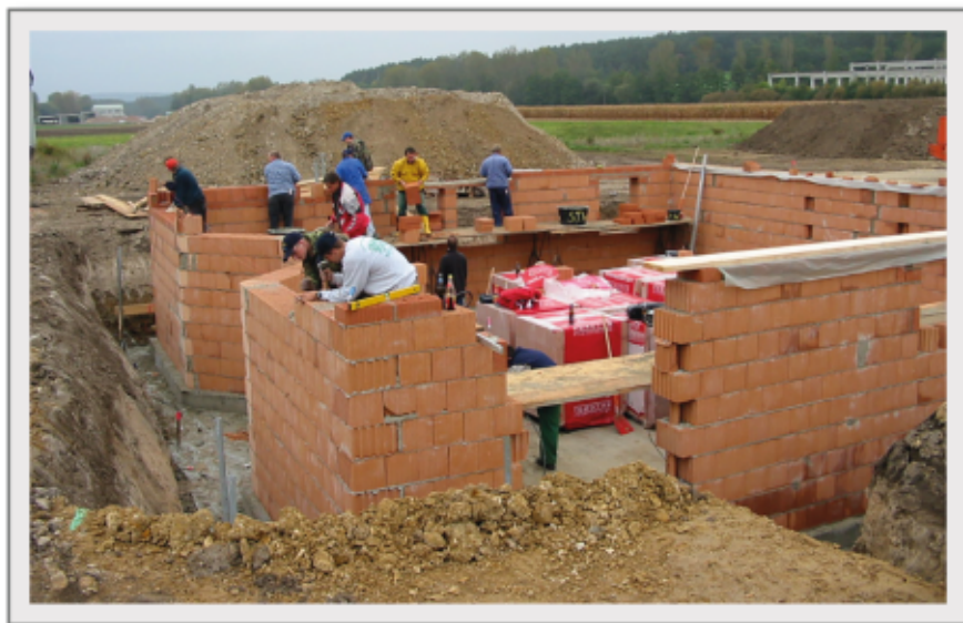
Beginn der Eigenleistungen am neuen Feuerwehrgerätehaus im Oktober 2002
