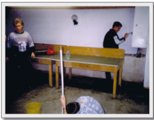
Renovierung des Schulungsraumes 1997
